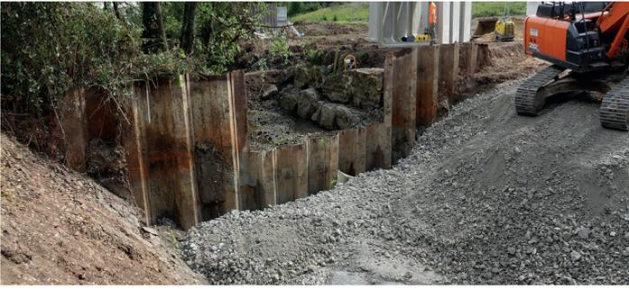
Afin de réaliser le terrassement dans de bonnes conditions, le chantier est mis hors d'eau. Des palplanches sont installées et une dérivation de la Reyssouze est mise en place.
