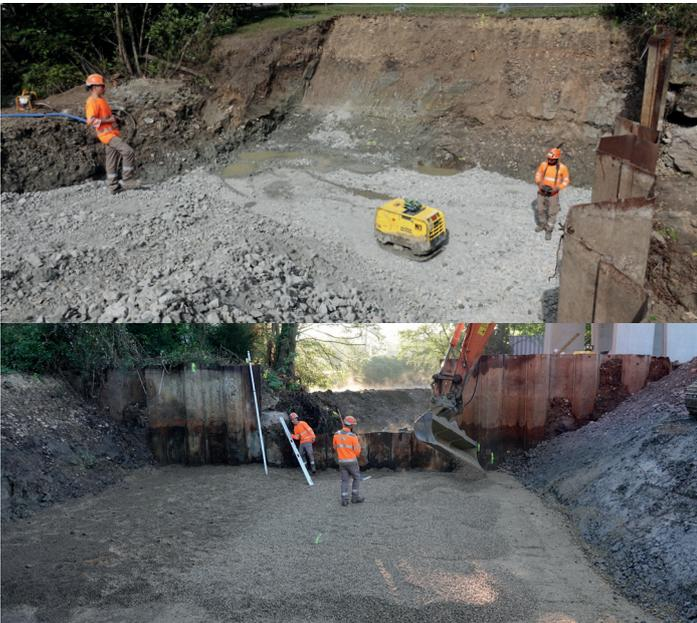
Le terrassement a permis de préparer le lit de pose de l'ouvrage à l'altitude prévue.
