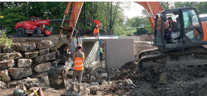
Des enrochements sont placés de part et d'autre du pont afin d'en assurer la solidité.
