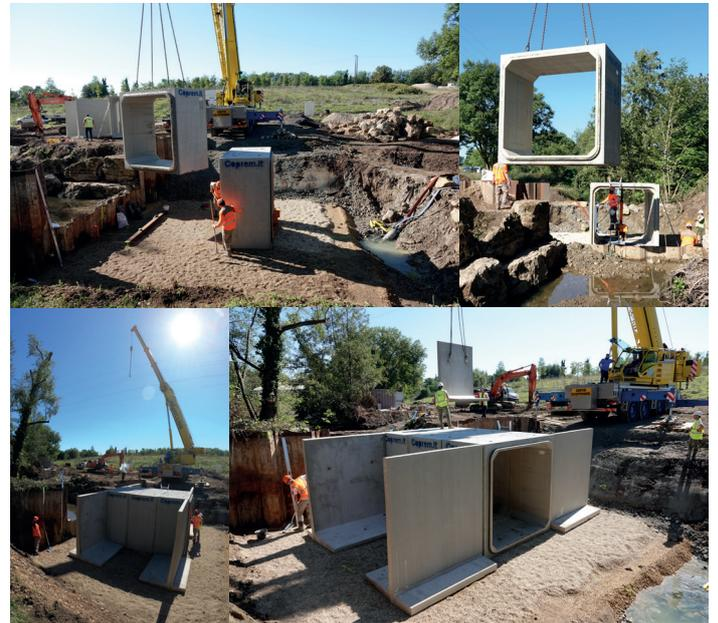
Le pont constitué de 3 cadres en béton pesant plus de 25 T a été installé grâce à une grue. Des joints sont installés entre chacun des éléments afin d'assurer l'étanchéité.
