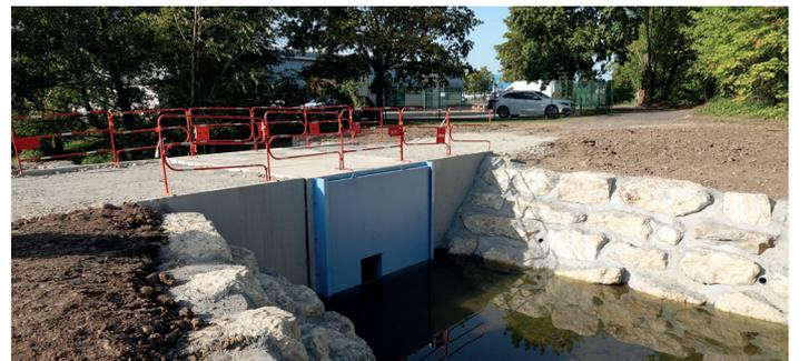
Un batardeau temporaire (plaque bleue) est installé à l'amont du pont afin de limiter le débit entrant dans le centre-ville de Bourg-en-Bresse afin de le protéger pendant les travaux de l'Allée de Challes.
