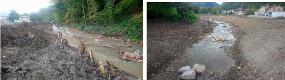
Figure 12 : diversification des écoulements blocs en diversification (Turdine-Tarare MOE Setec Hydratec)
