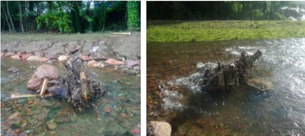
Figure 13 : diversification des écoulements : souche (Turdine-Tarare MOE Setec Hydratec).
