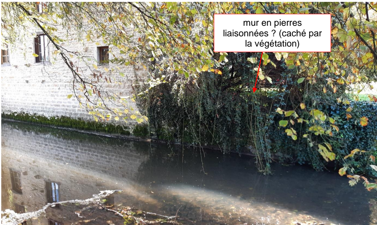
Photographie du muret rive gauche en aval immédiat du moulin datée du 16/11/2022 (source : ABO-ERG)
