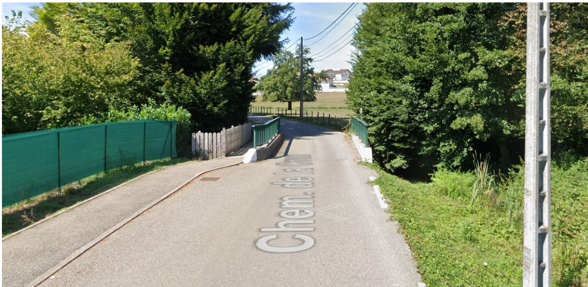
Photographie du pont depuis l'est (source : google.street.view)
