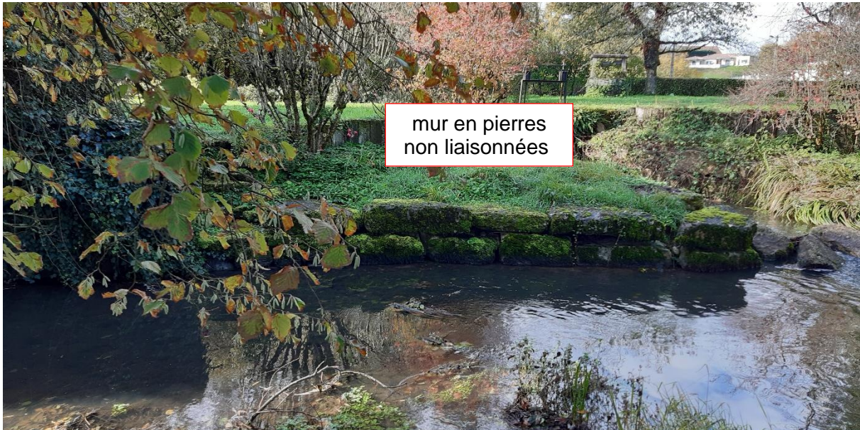
Photographie du muret rive gauche en aval du moulin datée du 16/11/2022 (source : ABO-ERG)
