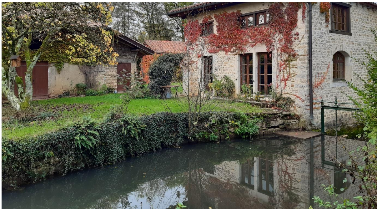
Photographie berge rive gauche en amont aménagée datée du 16/11/2022 (source : ABO-ERG)
