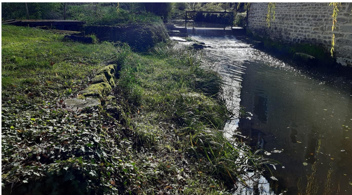
Photographie berge rive droite en amont aménagée datée du 16/11/2022 (source : ABO-ERG)
