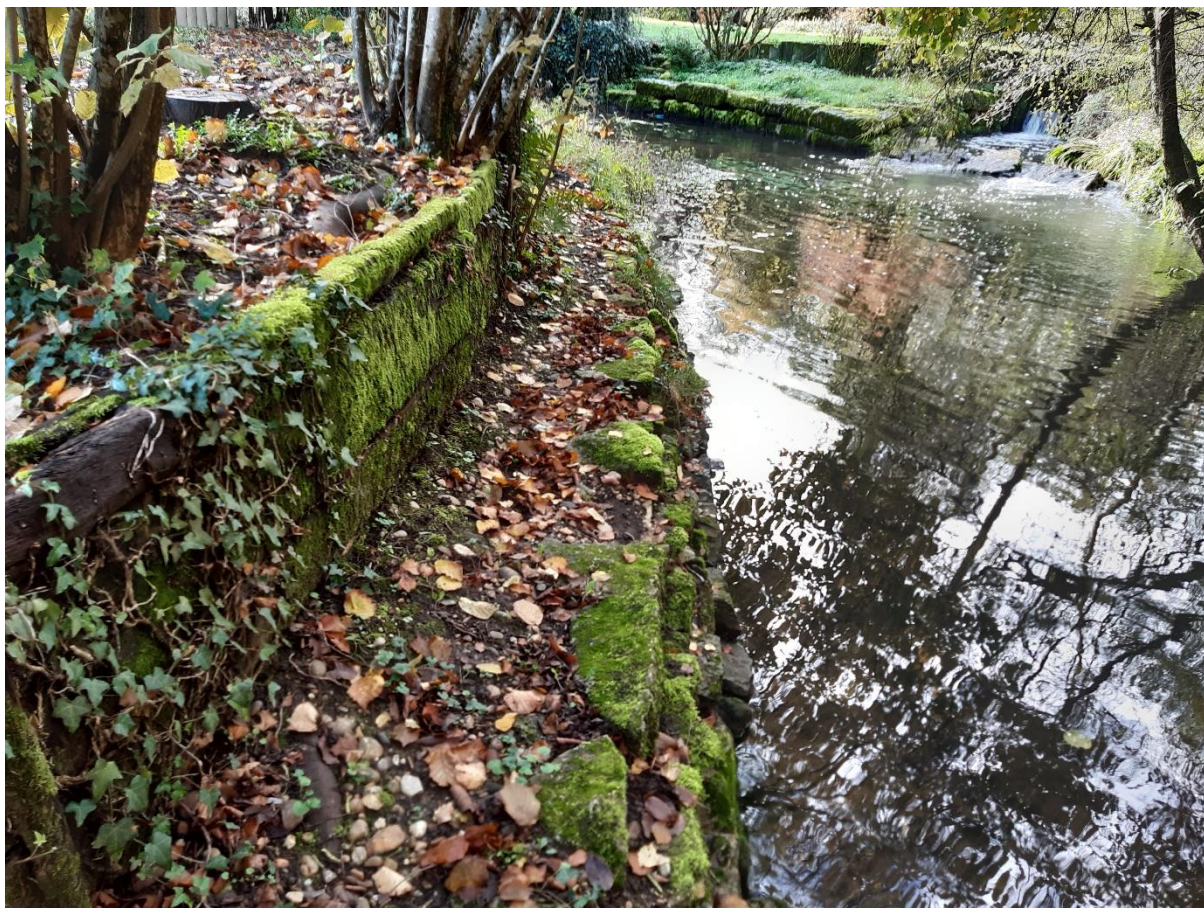
Photographie berge rive droite en amont aménagée datée du 16/11/2022 (source : ABO-ERG)
