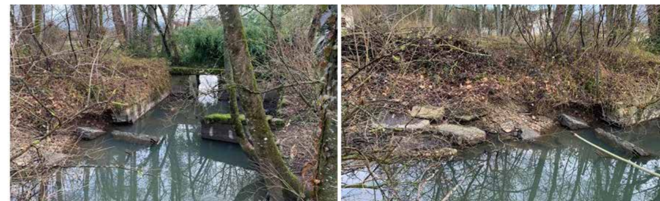
Figure 4 Vues de l'ouvrage de tête du bief (A) puis du bief lui-même permettant de délimiter les parcelles du moulin des espaces sportifs collectifs (clichés Biotec février 2022).
