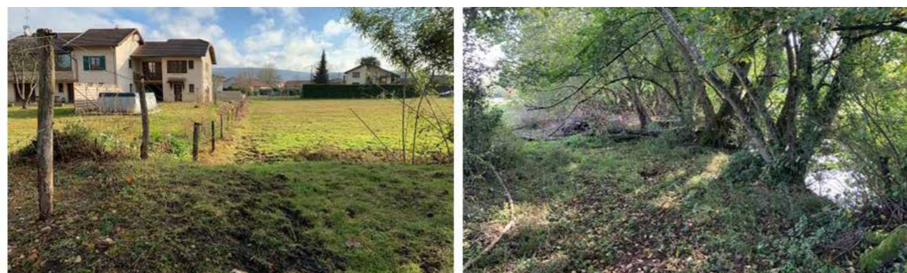
Figure 3 Vues aval puis amont (clichés Biotec février et juin 2022).
