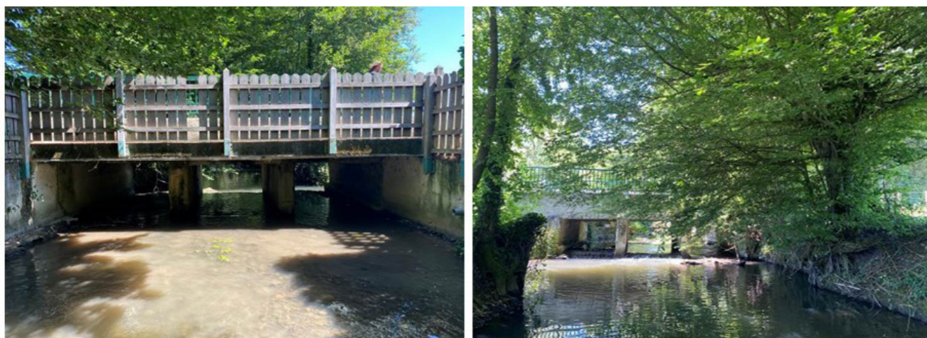
Figure 2 Vues amont (à gauche) et aval (à droite) de l'ouvrage permettant le franchissement de la route de la Craz (clichés Biotec 10.06.2022).
