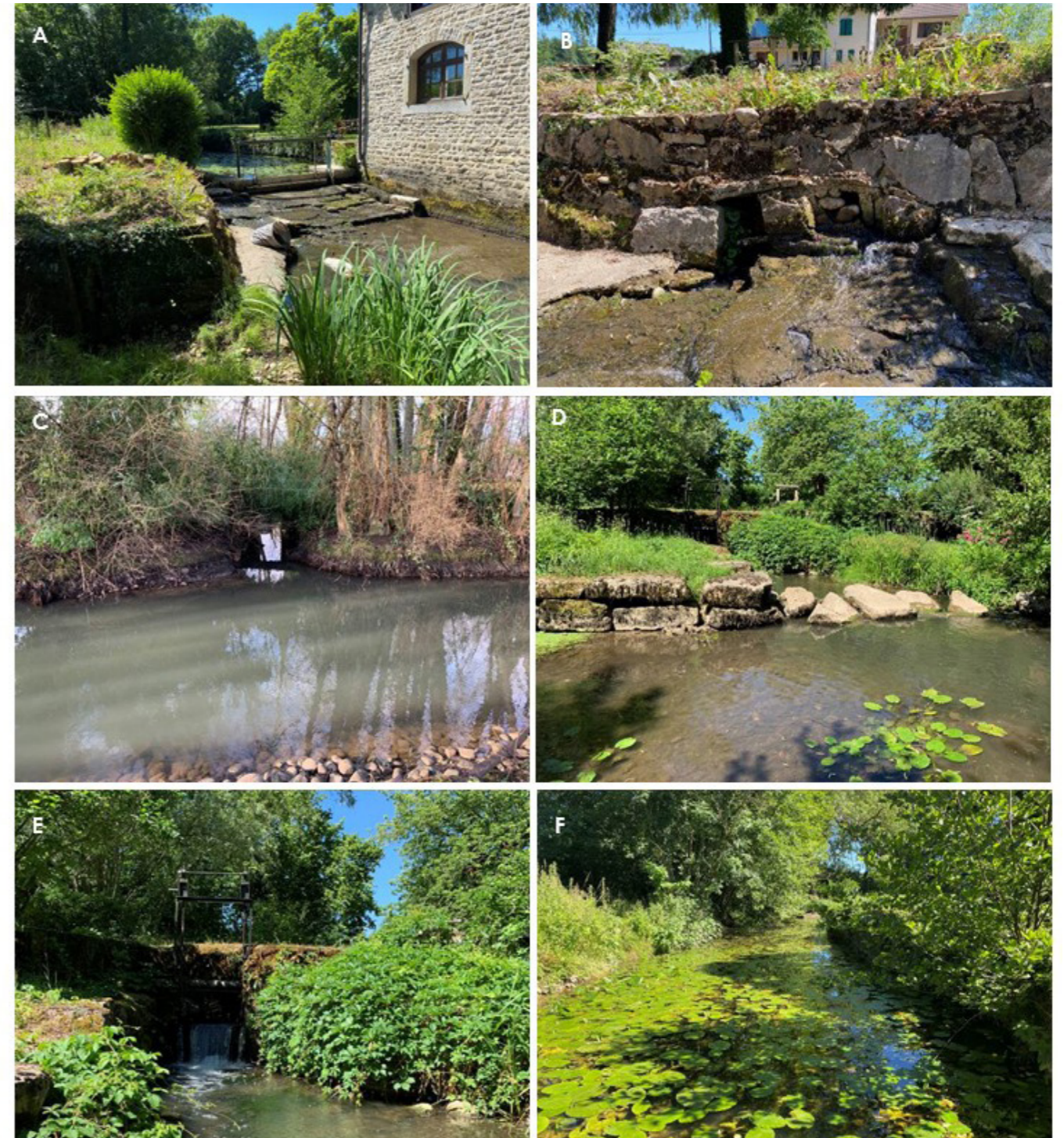
Figure 1 Illustrations de la chute générée par le complexe hydraulique du moulin de la Craz (A), de la vétusté et de la perméabilité de son génie civil (B) puis de la tête (C) et de l'exutoire (D, E) du bief dont il permet l'alimentation et enfin de l'effet retenue, éloigné des modèles naturels de la figure 1, qu'induit l'ouvrage (F) - clichés Biotec 10.06.2022.
