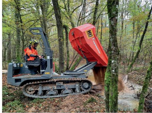
Mise en œuvre de 8 bouchons et 6 contre-bouchons.
