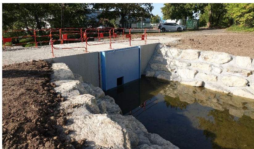
Figure 4-Batardeau temporaire (plaque bleue) limitant le débit au niveau du pont
