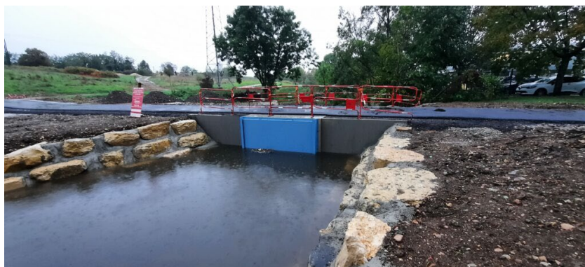
Figure 3-Passage de la Traverse sur le nouveau pont
