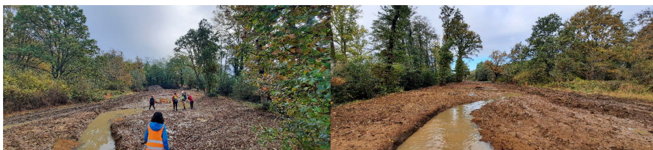
Figure 6-Terrassement des premiers méandres dans le marais
