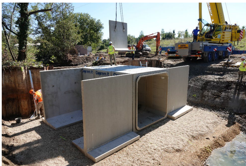
Figure 2-Installation du pont cadre en béton
