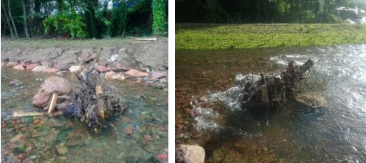
Figure 11 : diversification des écoulements : souche (Turdine-Tarare MOE Setec Hydratec).
