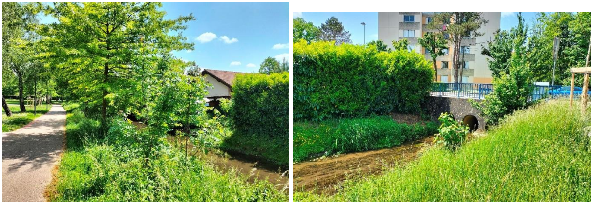
Figure 44 : Parc Dîmes-Revermont en rive gauche du Dévorah - Pont de la rue des Dîmes
