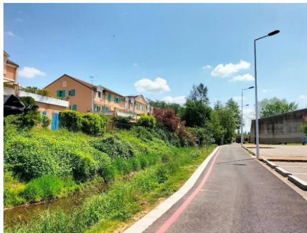
Figure 42 : Tronçon 13, vue depuis l'aval (haut) puis l'amont (bas)
