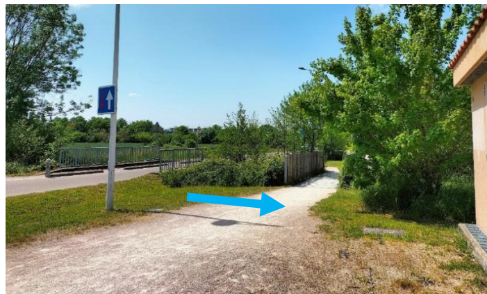
Figure 39 : Pont et passerelle de la Croix Blanche
