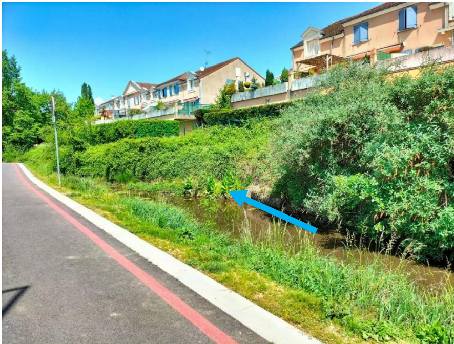
Figure 12 : Tronçon 13, vue depuis l'amont
