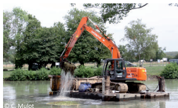
Pelle mécanique sur barge pour l'arrachage du Myriophylle du Brésil
