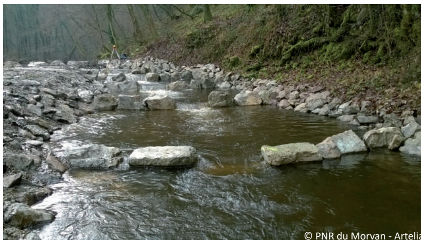
Exemple de passe à bassins successifs sur le Cousin (Avallon, 89)
